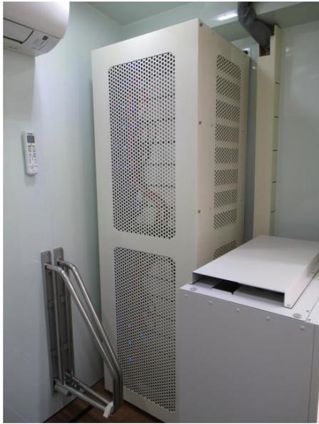
写真1：蓄電池方式の導入により、アイドリング時の大気汚染防止を実現。また会場内の他の検診車への電源供給や災害時のバックアップ電源としての活用も可能。
